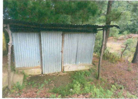
Foto 2: Mejoramiento de paredes en el cambio de cemento, instalacion de poyotón, piso, estructura de extracción de humo, cambio de puerta y colocación de balcón
