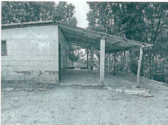
Foto 3: Cambio de pilares, estructura de techo madera a metal y cubierta de lámina troquelada calibre 26 del corredor
